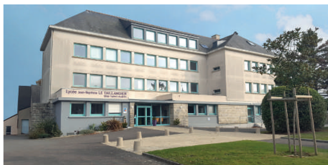
Site Saint Aubin à St-Aubin-du-Cormier
